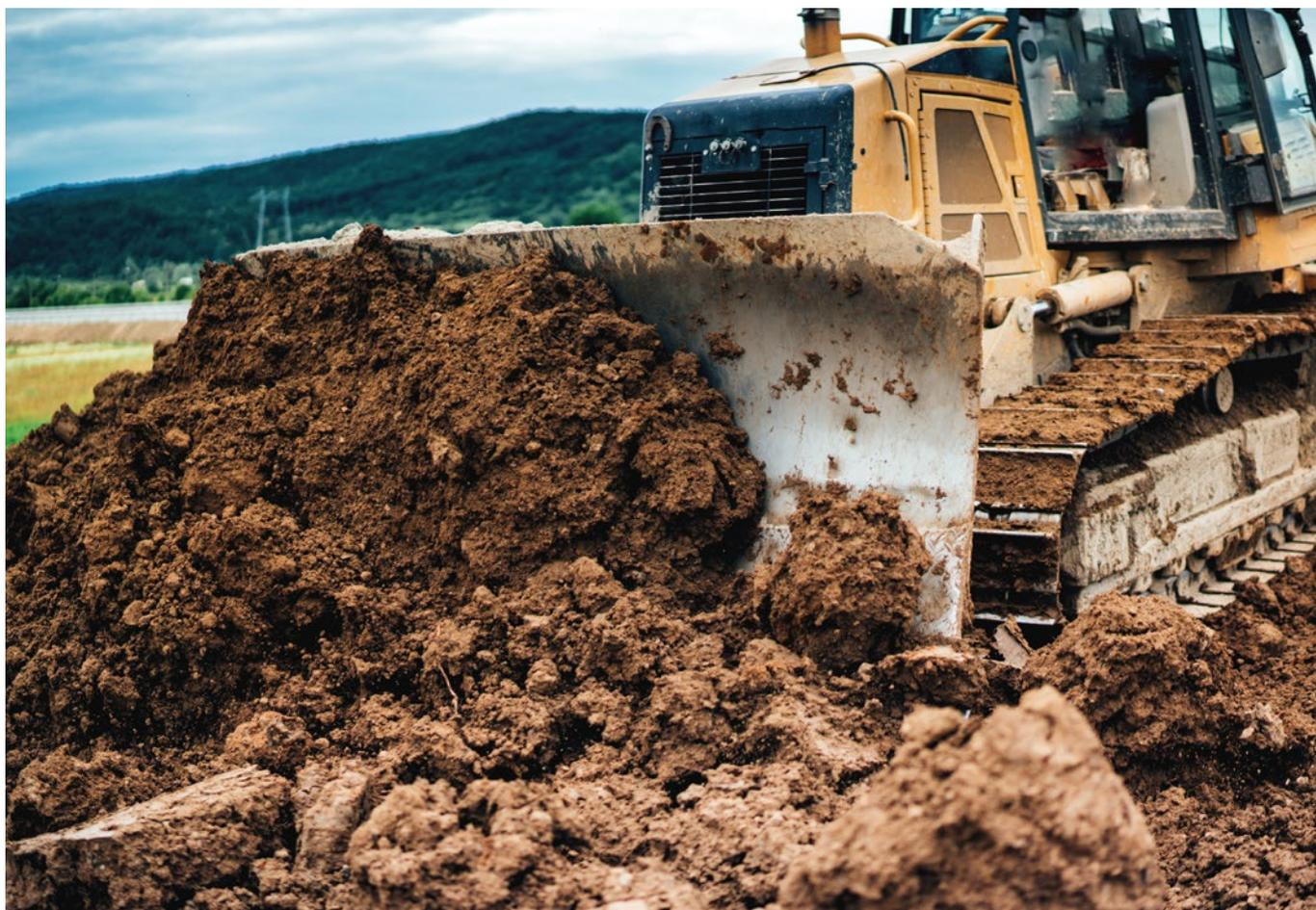
réalisées sur base de plans. En effet, les talus et imprévus de chantier engendrent fréquemment des surplus de terres par rapport aux prévisions initiales. Il est donc recommandé de toujours prévoir une marge de sécurité dans les projets, **supplémentaire à celle relative au foisonnement et prenant en compte les éventuelles surprofondeurs et talus latéraux.**
